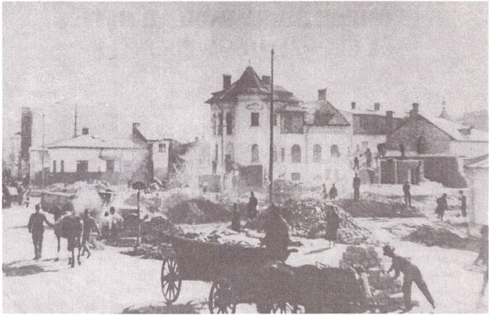
Fig. 6. Lucrările de demolare și reamenajare din str. Dr. Turnescu
