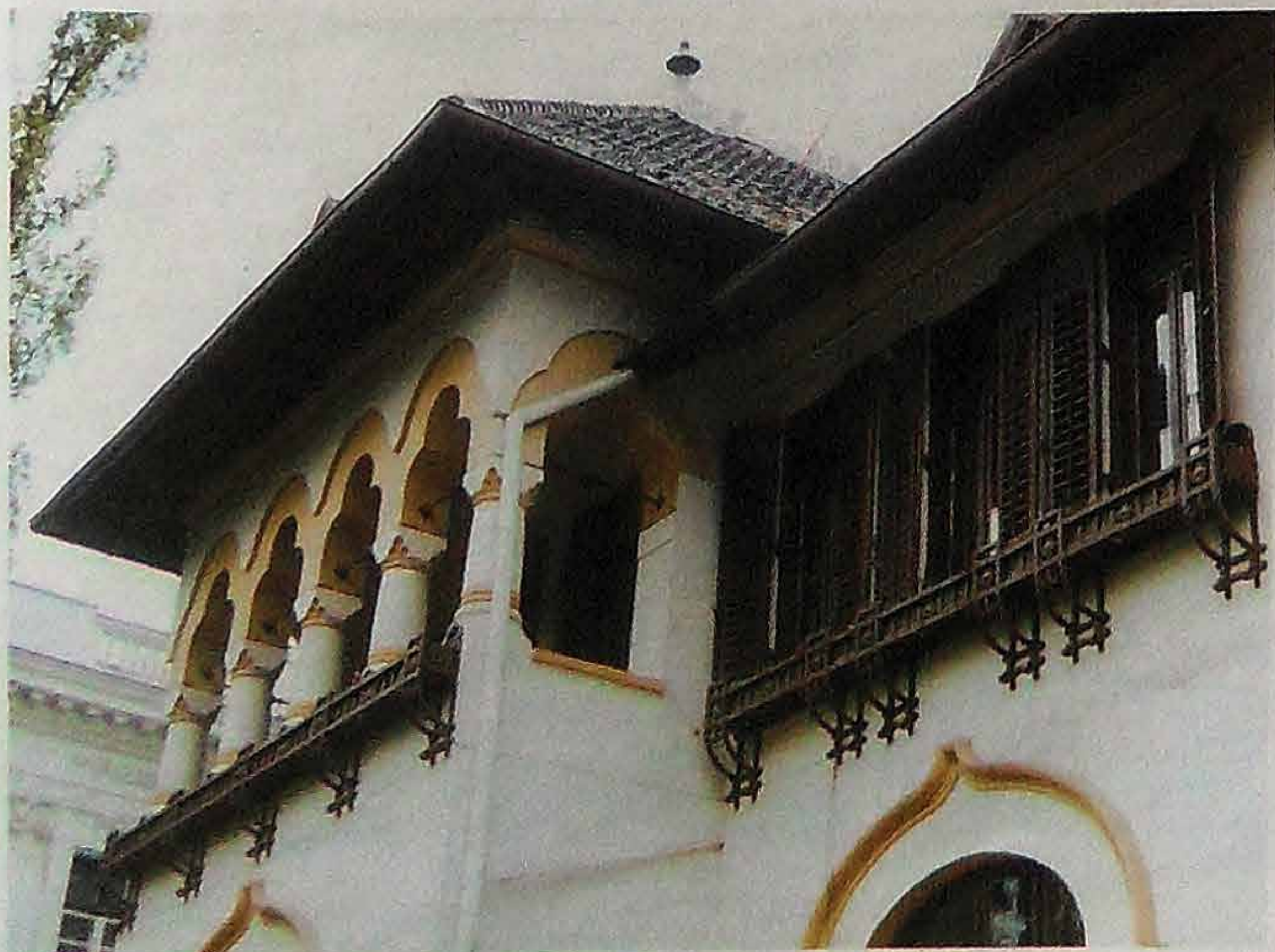
Detalii logie, fațada dinspre Strada Polonă.
