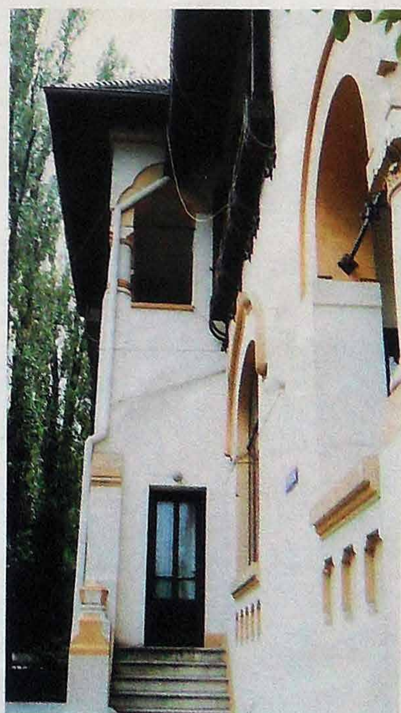
Detalii: Foișor - logie, Strada Polonă. Logie, fațada către parc. Intrare secundară.
