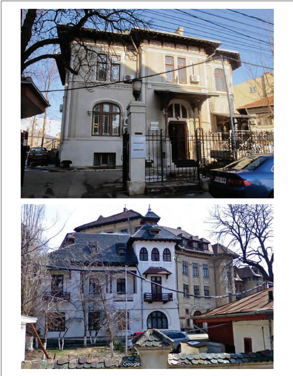
Pl. III. 1. Casa din str. Povernei nr. 2 (demolată la 9 mai 2011), foto februarie 2011 / House in Povernei St. N° 2 (demolished on 9 th of May 2011), photo: February 2011 ( http://silviacolfescu.blogspot.ro/2011/02/cateva-stradute-bucurestene-un.html ); 2. Vila și unul dintre pavilioanele administrative din str. Vasile Alecsandri, nr. 4 (demolate în 2009), foto martie 2009 / Villa and one of the administrative pavilions in Vasile Alecsandri St. N° 4 (demolished in 2009), photo: March 2009 ( https://www.google.ro/maps/ )
